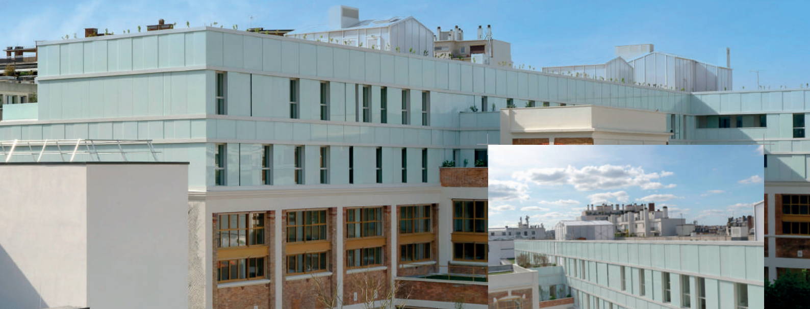
Rekonstrukce PARISTECH BUILDING - Paris
