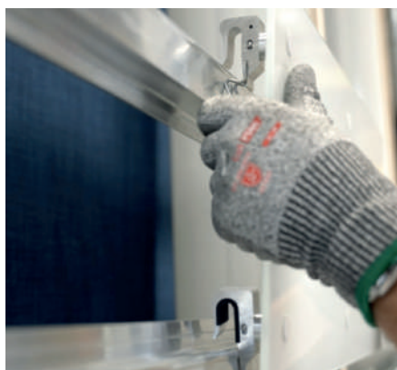
Zavěste vaše sklo pomocí háků na kolejnici
