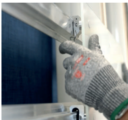
Vložte kroužek a šroub do zapuštěného otvoru v panelu a utáhněte jej pomocí šroubu.
